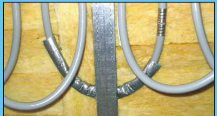
**FLUXPANEL-ELEMENT.** Rohrnetzverbindung fertig verpresst, Schlauchschutz
